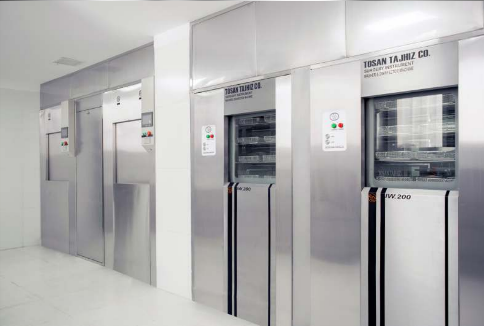
دیوار کشی استیل اطراف دستگاه اتوکلاو و واشینگ
